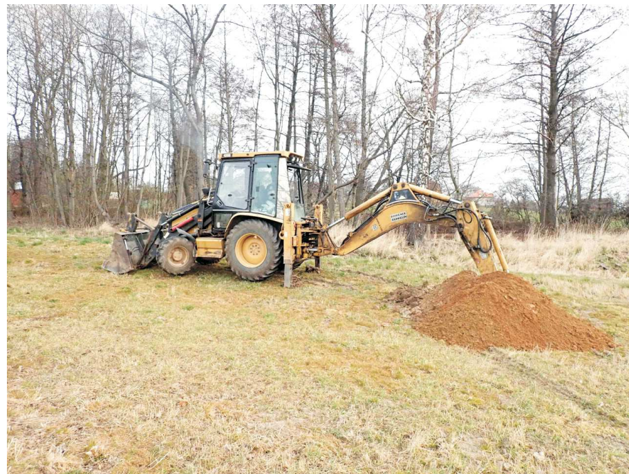
Foto 1. Bagr Caterpillar při realizaci kopané sondy KS6.
